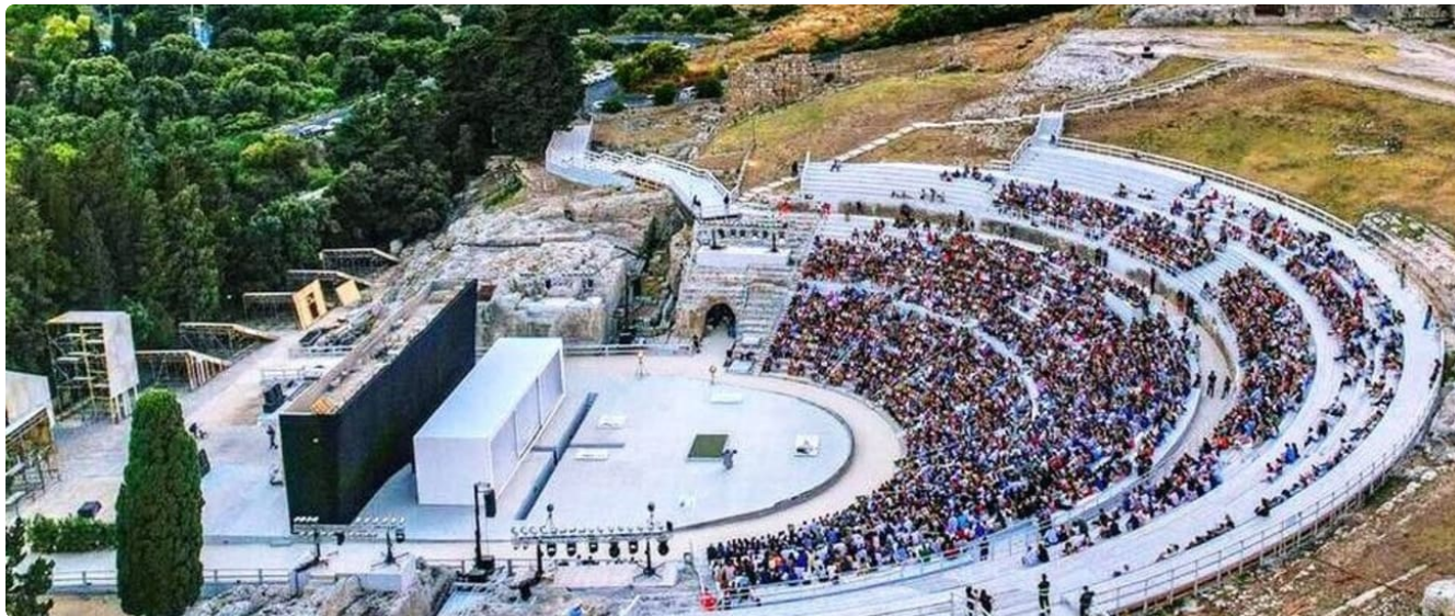
La cavea del Teatro Greco di Siracusa scavata nella roccia
