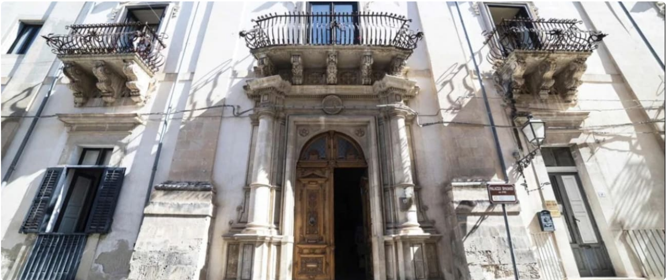
I balconi in ferro battuto di Palazzo Spadaro in via Mormina Penna a Scicli
